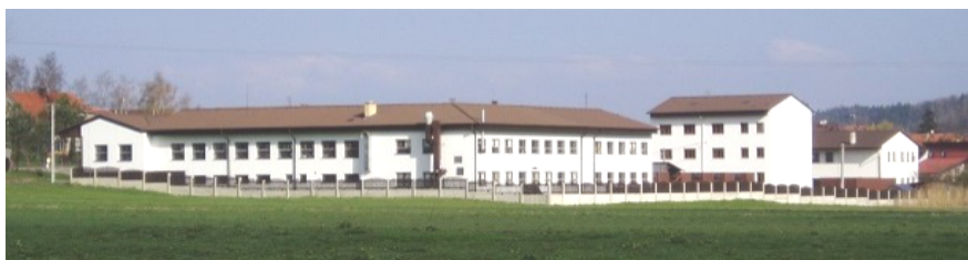
výrobní areál ve Štáhlavicích
